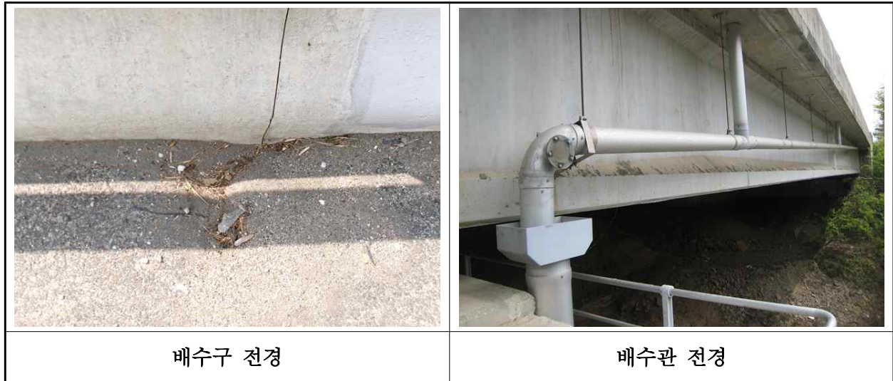
【사진 1.3.21】 배수시설 전경
