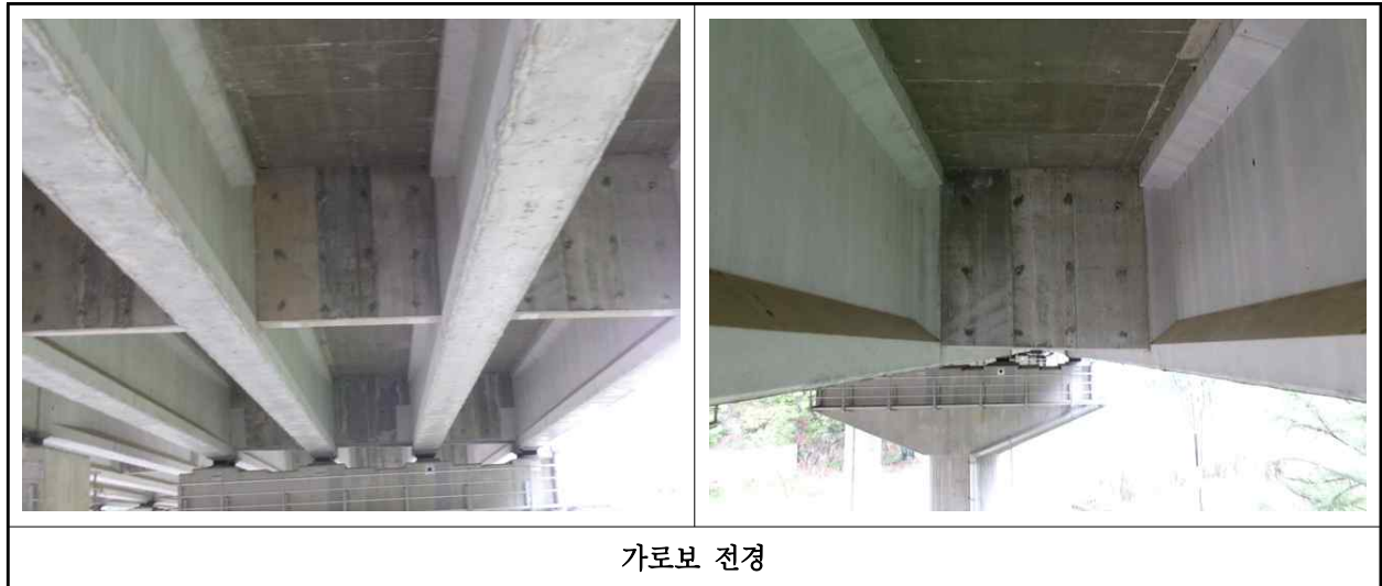
【사진 1.3.6】 가로보 전경
