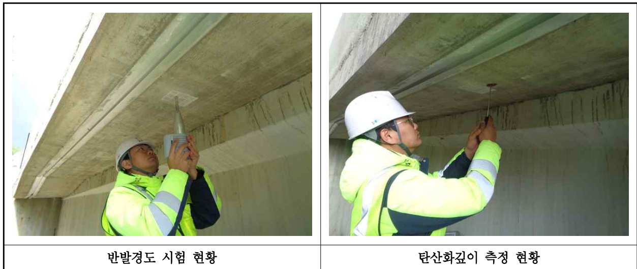
【사진 1.4.1】 콘크리트 내구성조사 현황
