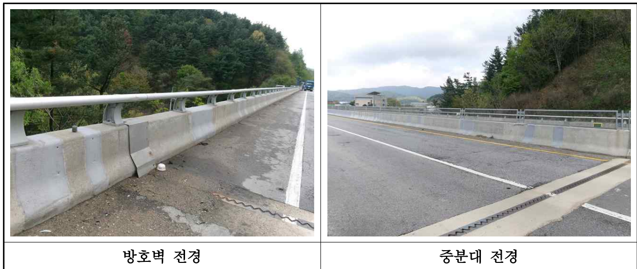
【사진 1.3.23】 방호벽 및 중앙분리대 전경
