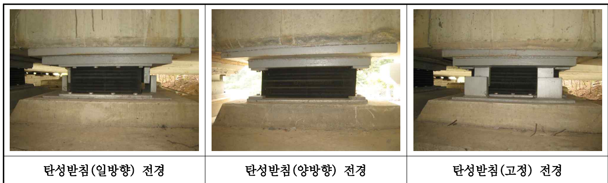
【사진 1.3.12】 교량받침 전경
