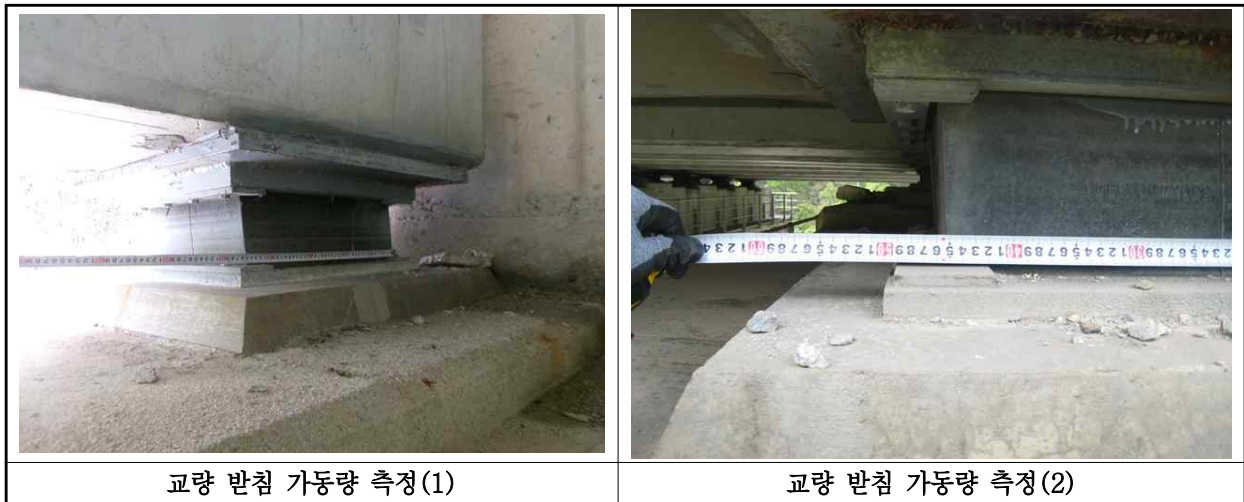
【사진 1.3.15】 교량받침 이동량 측정
