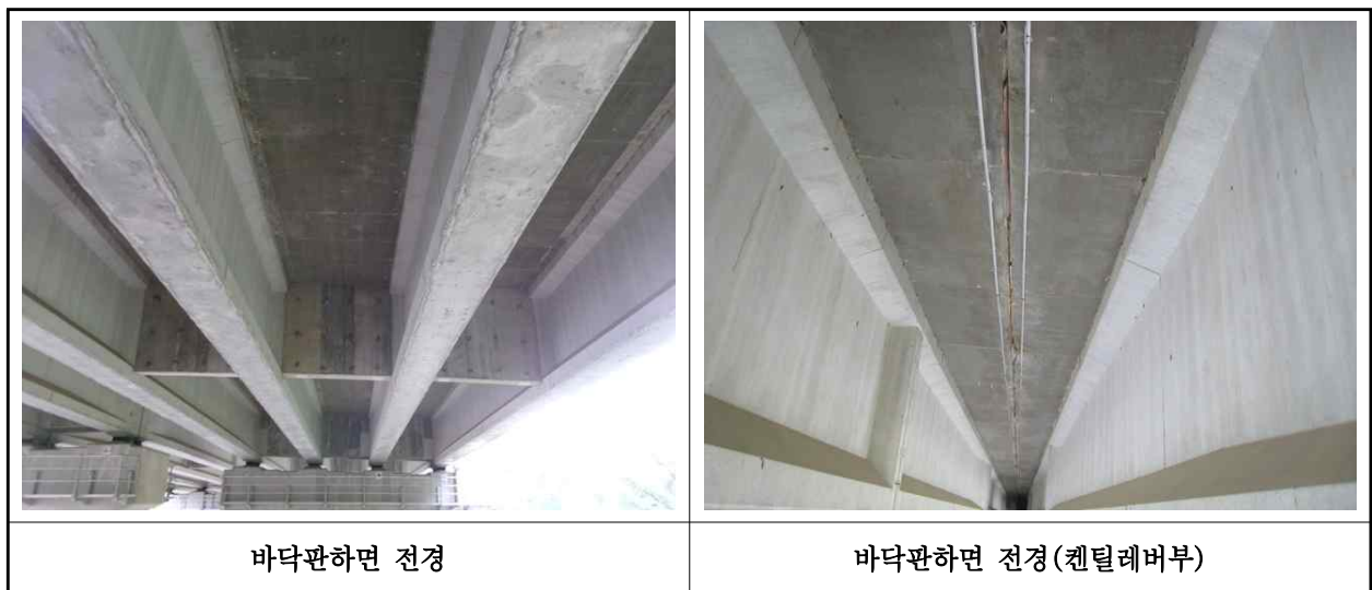
【사진 1.3.2】 바닥판하면 전경
