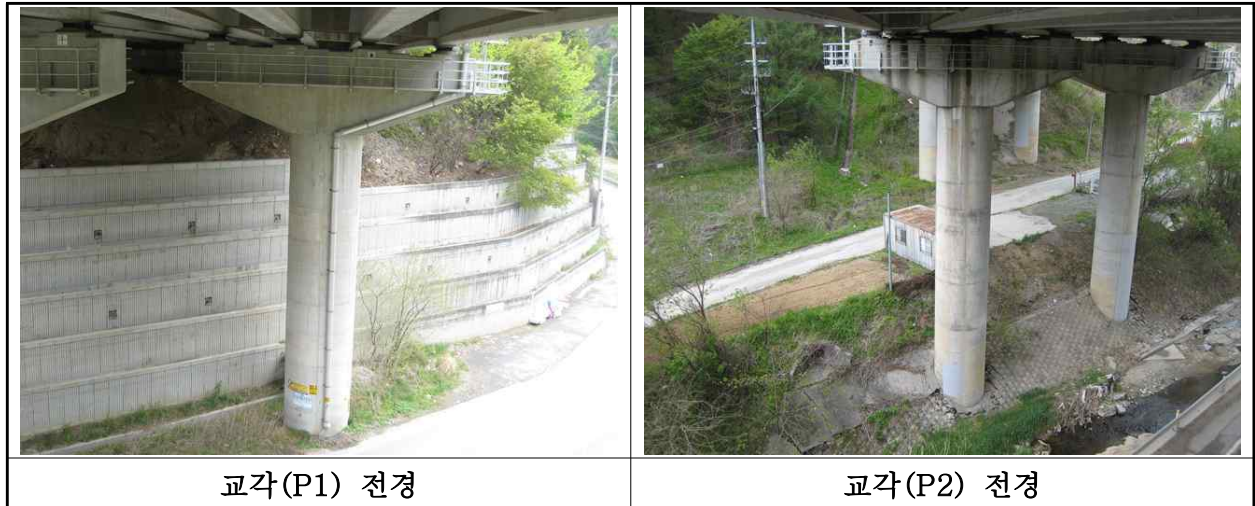
【사진 1.3.10】 교각 전경
