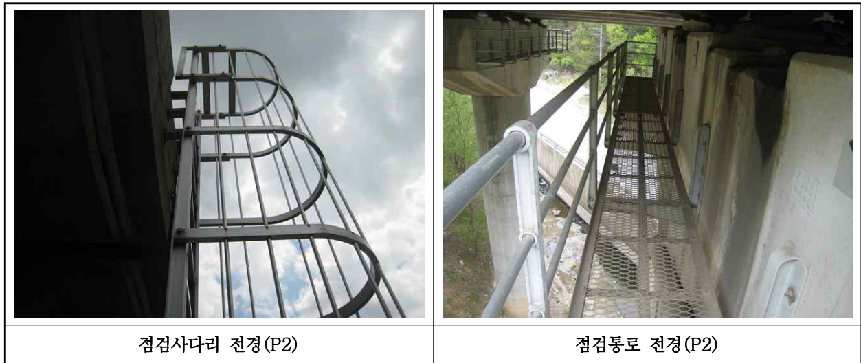
【사진 1.3.25】 교량 점검시설 전경
