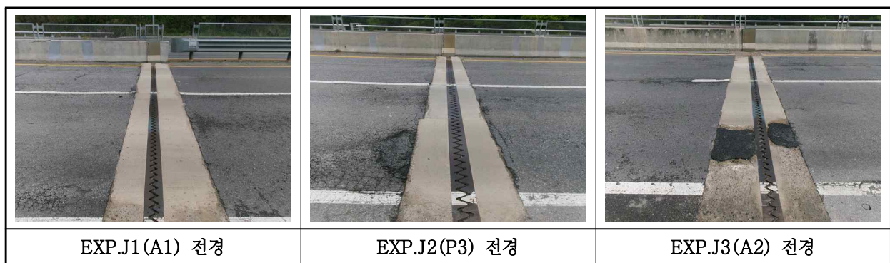
【사진 1.3.16】 신축이음장치 전경
