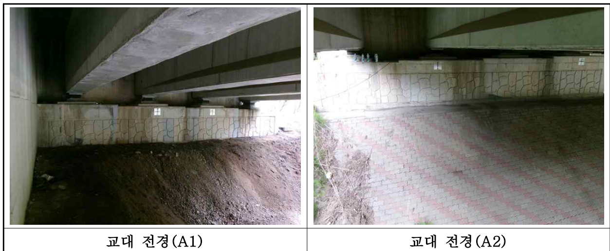
【사진 1.3.8】 교대 전경
